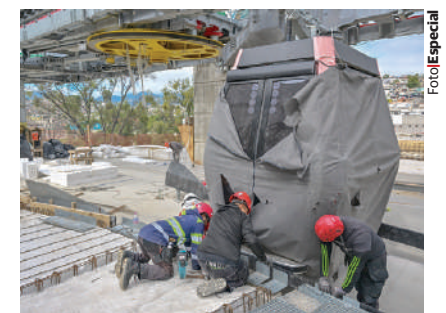
TRABAJADORES montan canastilla de la nueva infraestructura, en imagen de archivo.
